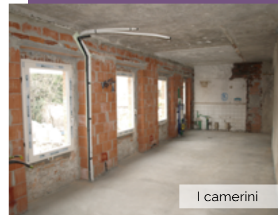
l'interno del cantiere
